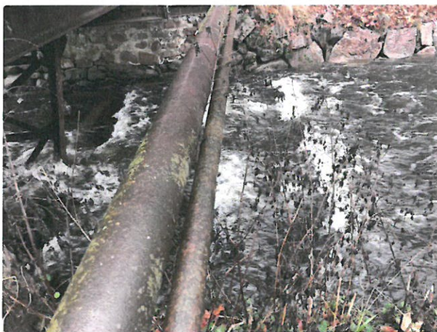
IMG_8212 - Chráničky inženýrských sítí jsou zkorodované a bez PKO
