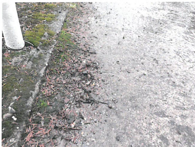
IMG_8145 - Podél pravé římsy jsou nečistoty
