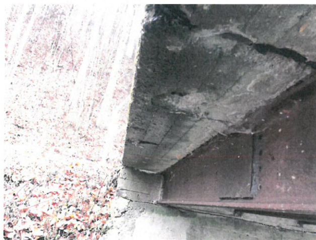
IMG_8227 - Na podhledu NK se lokálně vyskytují stopy po zatékání, obnažené třmínky, napade
