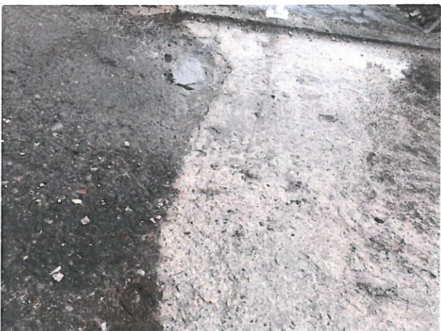
IMG_8129 - Na přechodu na mostovku na konci mostu jsou patrné trhliny, ale pravděpodobně těsné
