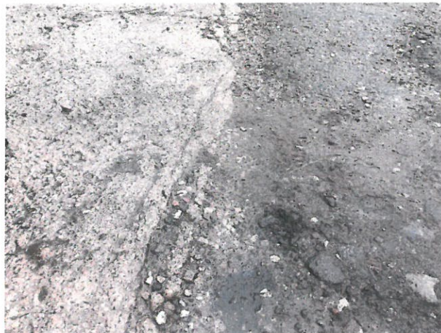
IMG_8119 - Na přechodu na mostovku na začátku mostu jsou patrné trhliny, ale pravděpodobně tě
