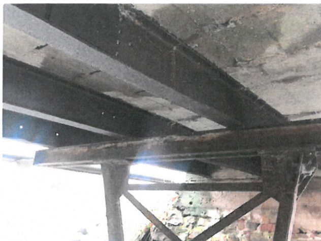
IMG_8235 - PKO NK je dožilá, plošně se vyskytuje prozatím povrchová korozie
