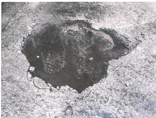
IMG_8122 - Na vozovce na objektu vlevo je velký výtluk, porucha izolace!
