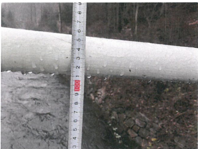
IMG_8137 - Výška zábradlí je 1060mm, nesplňuje současné normové požadavky
