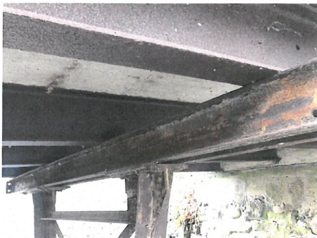
IMG_8221 - Dodatečné podepření NK je bez PKO, prozatím povrchová koroze, tvoří překážku v
