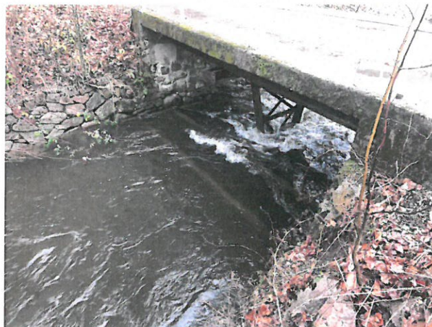
IMG_8237 - porovizorní podepření v polovině rozpětí NO tvoří překážku v průtočném prof
