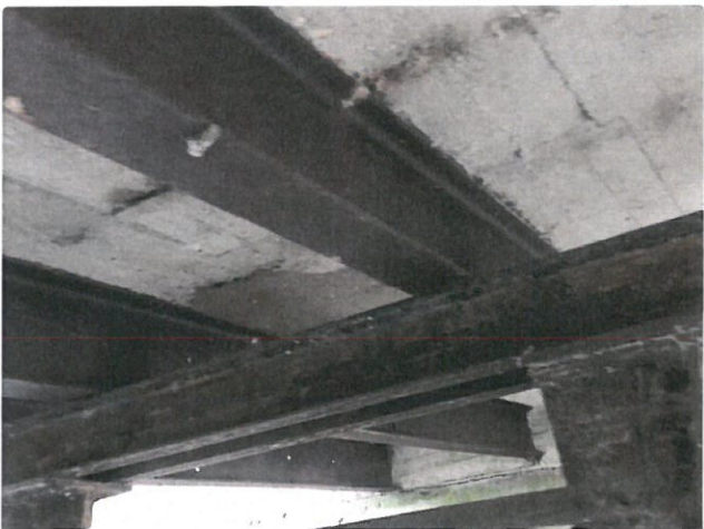
IMG_8232 - Na podhledu NK se lokálně vyskytují stopy po zatékání, obnažené třmínky, napade
