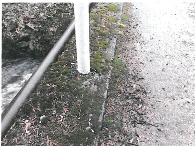
IMG_8144 - Pravá římsa je porostlá mechem, bok poteklý
