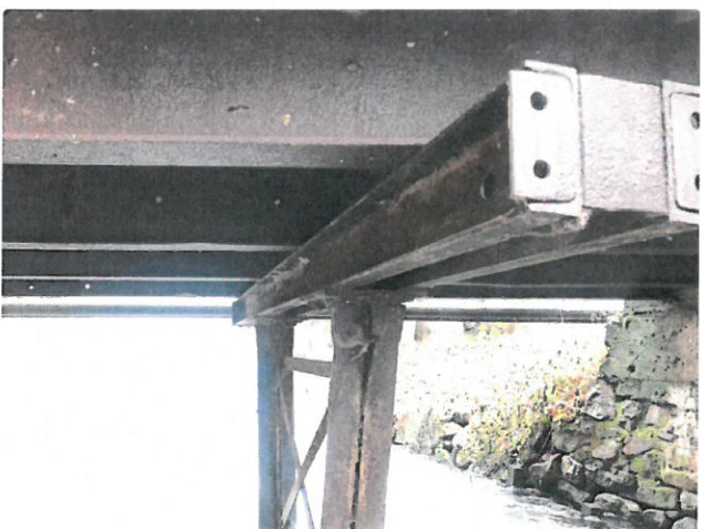
IMG_8219 - Dodatečné podepření NK je bez PKO, prozatím povrchová koroze, tvoří překážku v
