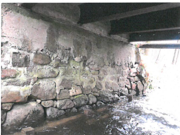
IMG_8171 - Opěra O2 má rozvolněné zdivo bez výplně spár
