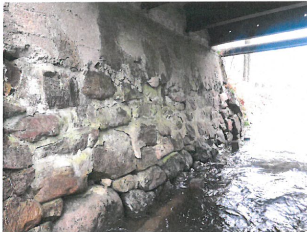
IMG_8170 - Opěra O2 má rozvolněné zdivo bez výplně spár
