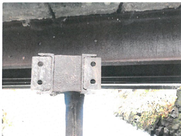
IMG_8218 - Dodatečné podepření NK je bez PKO, prozatím povrchová koroze, tvoří překážku v
