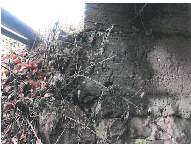
IMG_8156 - Křídlo K2 (navazující opěrná zídka má rozvolněné zdivo bez výplně spár
