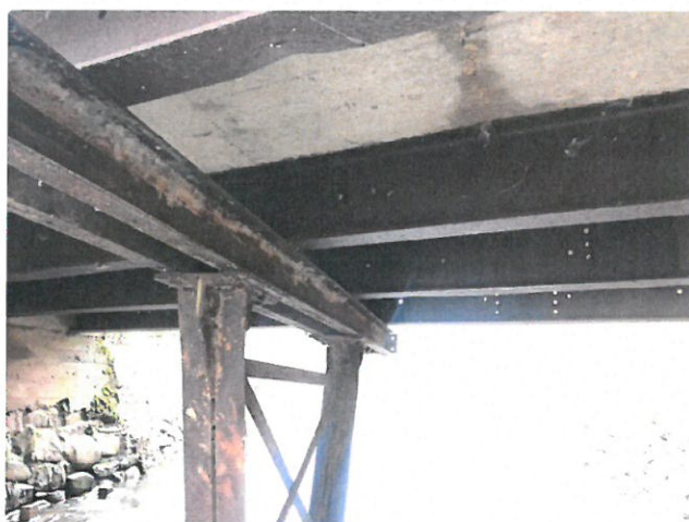
IMG_8223 - Dodatečné podepření NK je bez PKO, prozatím povrchová koroze, tvoří překážku v
