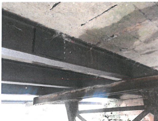
IMG_8199 - PKO NK je dožilá, plošně se vyskytuje prozatím povrchová koroze
