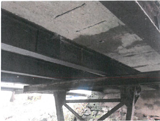
IMG_8234 - Na podhledu NK se lokálně vyskytují stopy po zatékání, obnažené třmínky, napade
