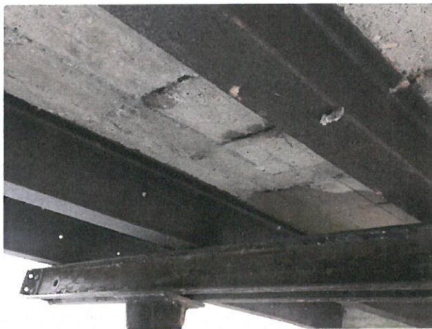
IMG_8231 - Na podhledu NK se lokálně vyskytují stopy po zatékání, obnažené třmínky, napade
