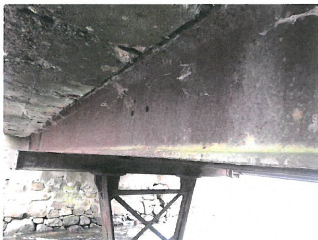
IMG_8182 - PKO NK je dožilá, plošně se vyskytuje prozatím povrchová koroze
