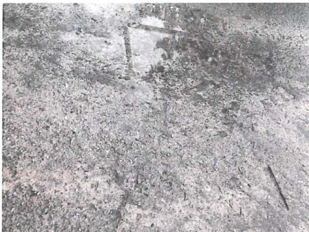
IMG_8125 - povrchová degradace vozovky na mostě
