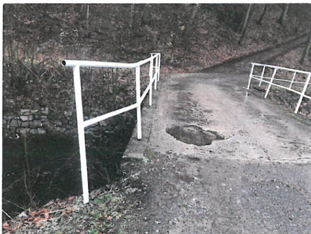
IMG_8135 - Levé zábradlí je vykloněné
