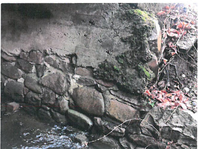
IMG_8151 - Opěra O1 má rozvolněné zdivo bez výplně spár
