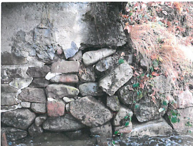
IMG_8174 - Opěra O2 má rozvolněné zdivo bez výplně spár
