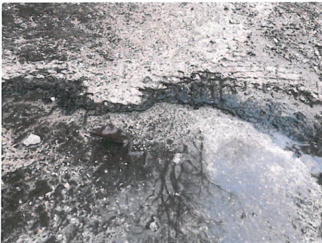
IMG_8124 - Na vozovce na objektu vlevo je velký výtluk, porucha izolace!
