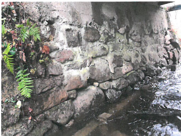
IMG_8169 - Opěra O2 má rozvolněné zdivo bez výplně spár
