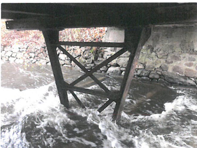
_most je v polovině rozpětí dodatečně podepřen ocelovou podpěrou
