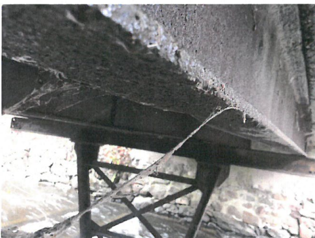
IMG_8209 - PKO NK je dožilá, plošně se vyskytuje prozatím povrchová koroze
