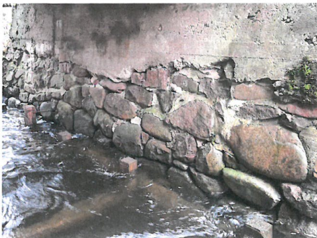
IMG_8153 - Opěra O1 má rozvolněné zdivo bez výplně spár
