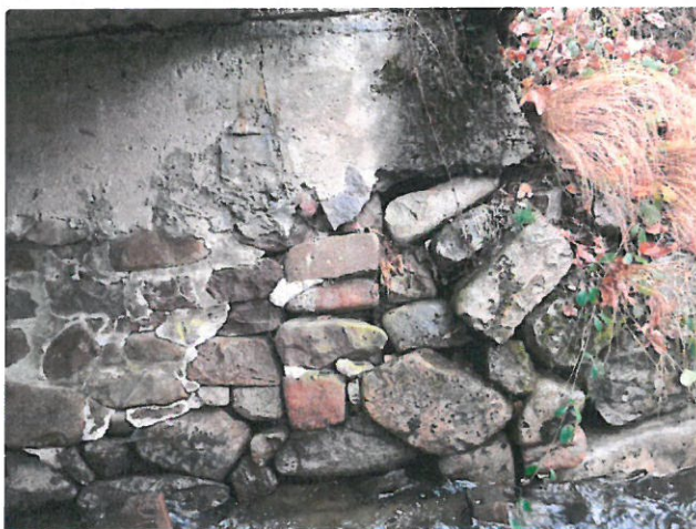
IMG_8172 - Opěra O2 má rozvolněné zdivo bez výplně spár
