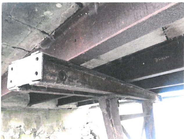
IMG_8220 - Dodatečné podepření NK je bez PKO, prozatím povrchová koroze, tvoří překážku v
