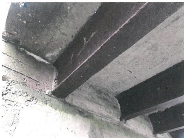
IMG_8215 - Na opěře O1 jsou stopy po zatékání
