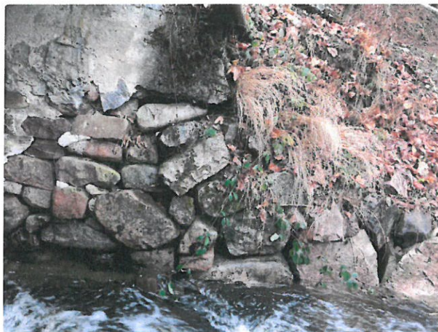
IMG_8177 - Křídlo K4 (navazující opěrná zídka) má rozvolněné zdivo bez výplně spár
