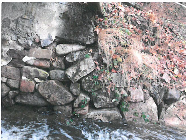
IMG_8176 - Křídlo K4 (navazující opěrná zídka) má rozvolněné zdivo bez výplně spár
