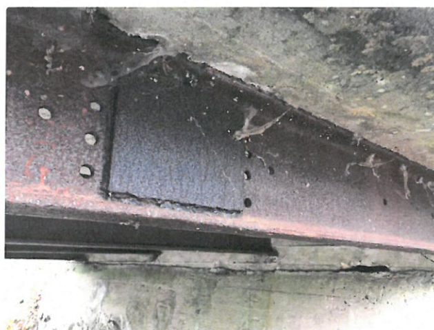
IMG_8224 - PKO NK je dožilá, plošně se vyskytuje prozatím povrchová koroze
