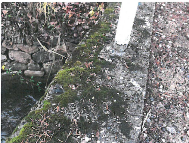
IMG_8138 - Levá římsa je porostlá mechem, bok poteklý
