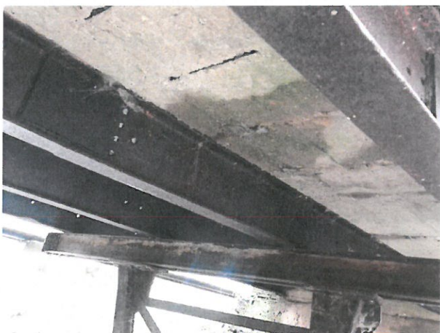
IMG_8198 - PKO NK je dožilá, plošně se vyskytuje prozatím povrchová koroze
