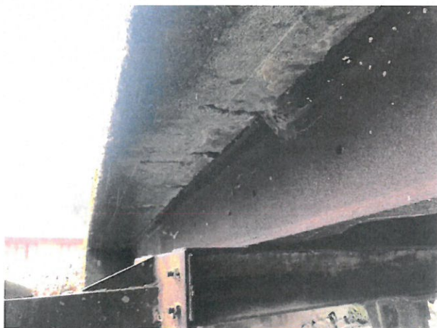
IMG_8225 - PKO NK je dožilá, plošně se vyskytuje prozatím povrchová koroze
