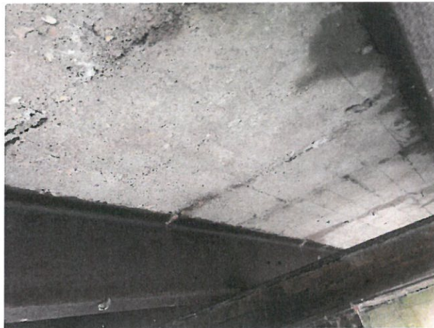
IMG_8229 - Na podhledu NK se lokálně vyskytují stopy po zatékání, obnažené třmínky, napade
