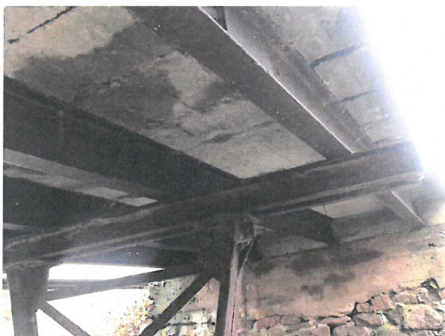
IMG_8217 - Na podhledu NK se lokálně vyskytují stopy po zatékání, obnažené třmínky, napade
