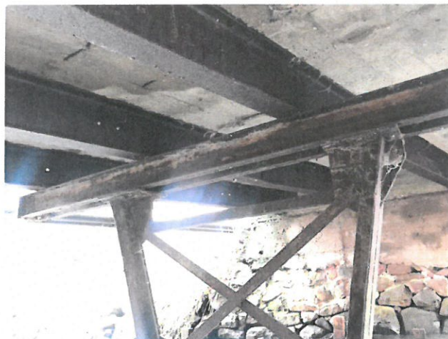
IMG_8201 - Dodatečné podepření NK je bez PKO, prozatím povrchová koroze, tvoří překážku v
