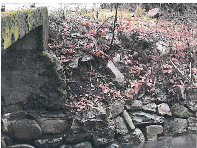
IMG_8148 - Křídlo K1 (navazující opěrná zídka) má rozvolněné zdivo bez výplně spár
