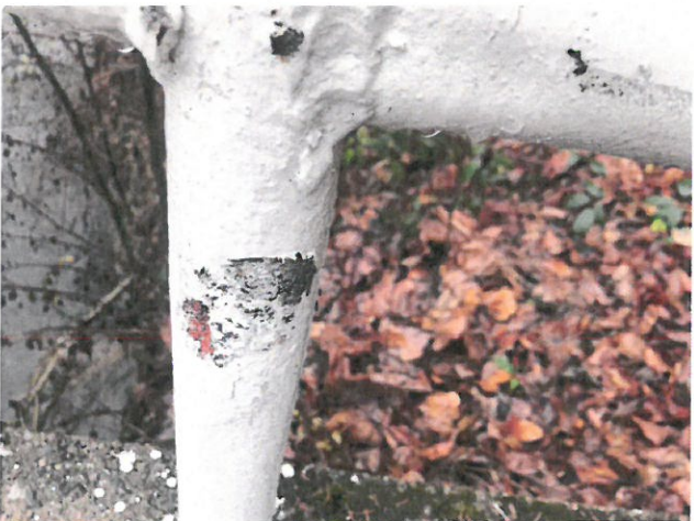
IMG_8139 - PKO zábradlí je lokálně porušená, lokálně se vyskytuje koroze
