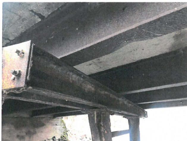
IMG_8222 - Dodatečné podepření NK je bez PKO, prozatím povrchová koroze, tvoří překážku v
