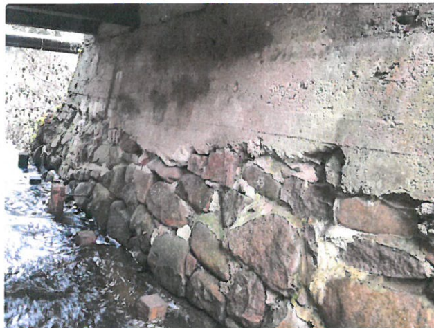
IMG_8154 - Opěra O1 má rozvolněné zdivo bez výplně spár
