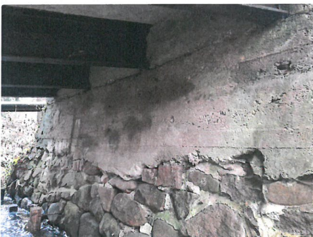
IMG_8152 - Na opěře O1 jsou stopy po zatékání
