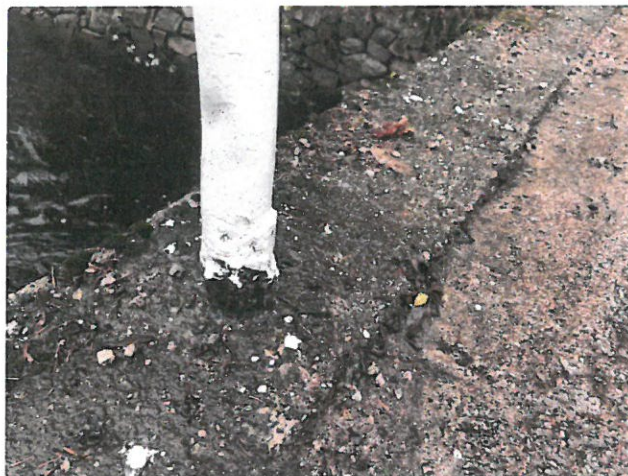
IMG_8136 - PKO zábradlí je lokálně porušená, lokálně se vyskytuje koroze
