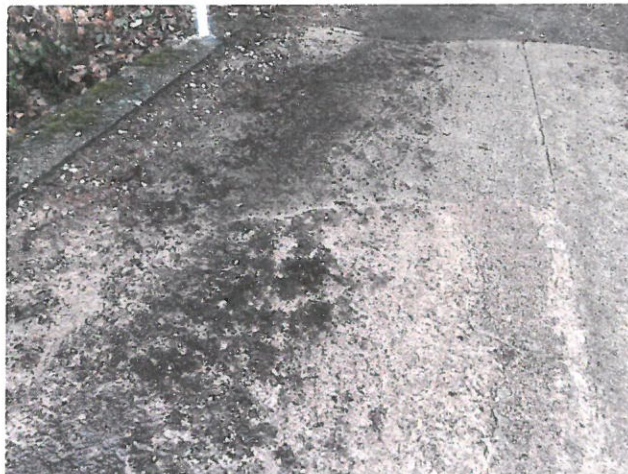
IMG_8126 - povrchová degradace vozovky na mostě
