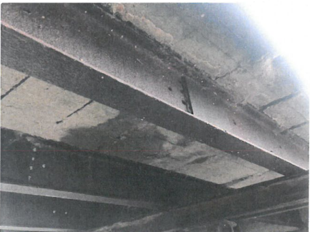
IMG_8213 - PKO NK je dožilá, plošně se vyskytuje prozatím povrchová koroze
