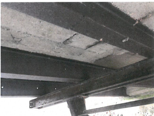
IMG_8230 - Na podhledu NK se lokálně vyskytují stopy po zatékání, obnažené třmínky, napade
