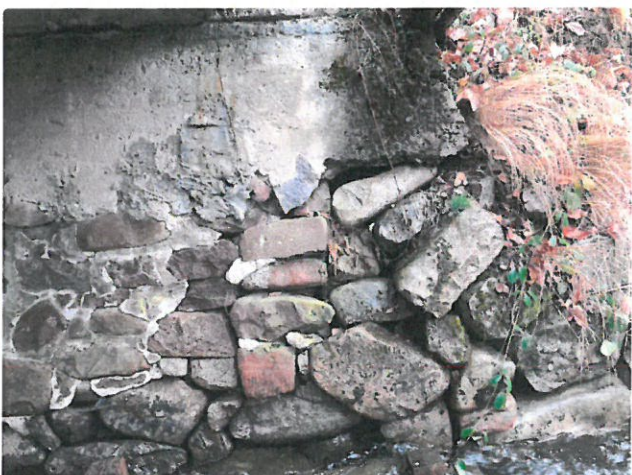
IMG_8173 - Opěra O2 má rozvolněné zdivo bez výplně spár
