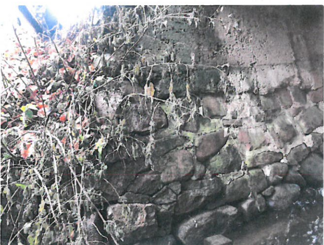
IMG_8162 - Křídlo K2 (navazující opěrná zídka) má rozvolněné zdivo bez výplně spár
