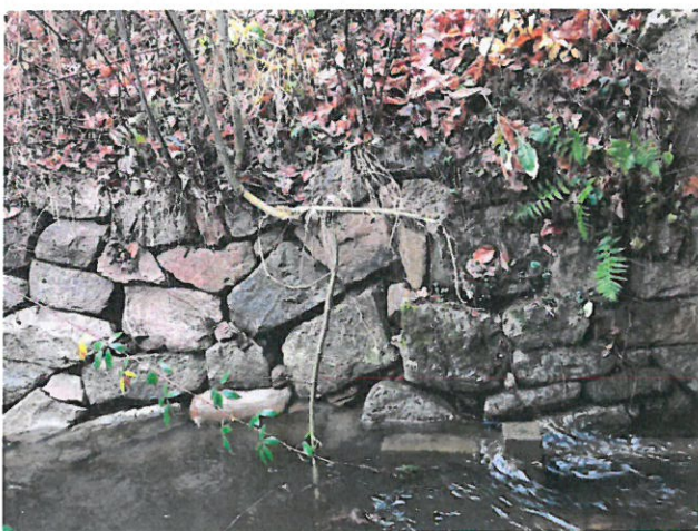
IMG_8166 - Křídlo K3 (navazující opěrná zídka) má rozvolněné zdivo bez výplně spár
