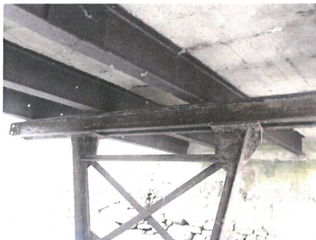
IMG_8184 - Dodatečné podepření NK je bez PKO, prozatím povrchová koroze, tvoří překážku v
