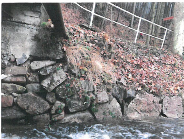
_Pravé křídlo na konci mostu (K4), (navazující opěrná zeď)
