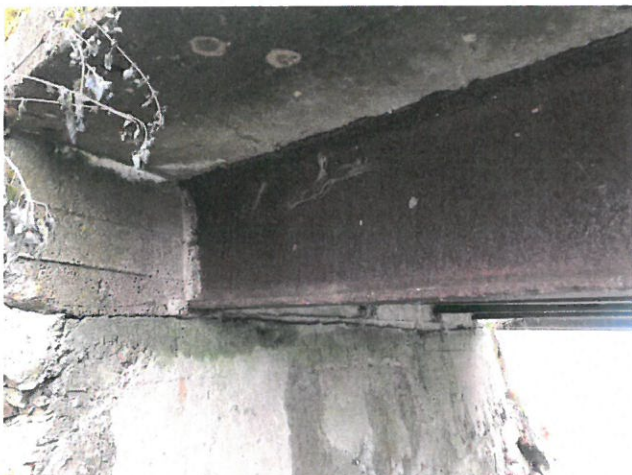
IMG_8228 - PKO NK je dožilá, plošně se vyskytuje prozatím povrchová koroze
