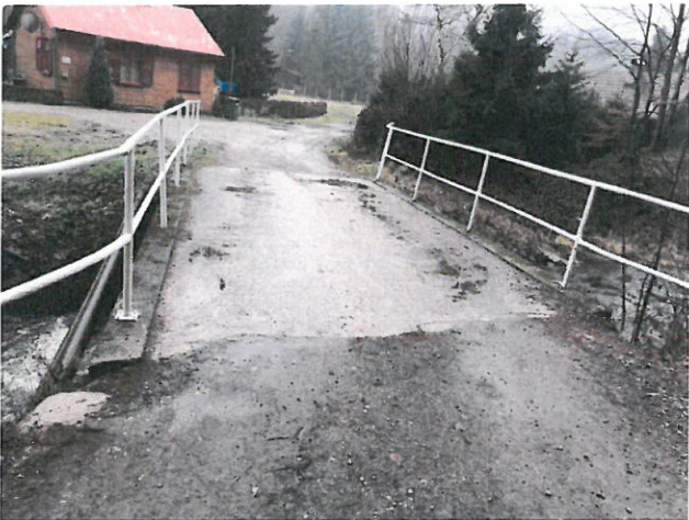
IMG_8143 - Pravé zábradlí je vykloněné
