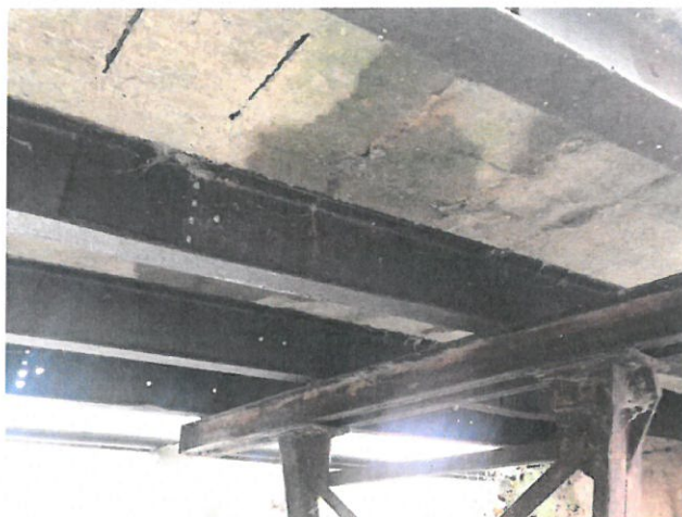
IMG_8216 - Na podhledu NK se lokálně vyskytují stopy po zatékání, obnažené třmínky, napade
