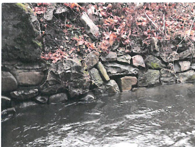
IMG_8149 - Křídlo K1 (navazující opěrná zídka) má rozvolněné zdivo bez výplně spár
