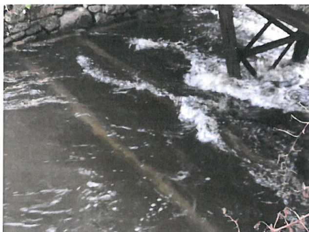
IMG_8238 - na dně toku je provizorní rozepření opěr, které tvoří překážku v průtočném
