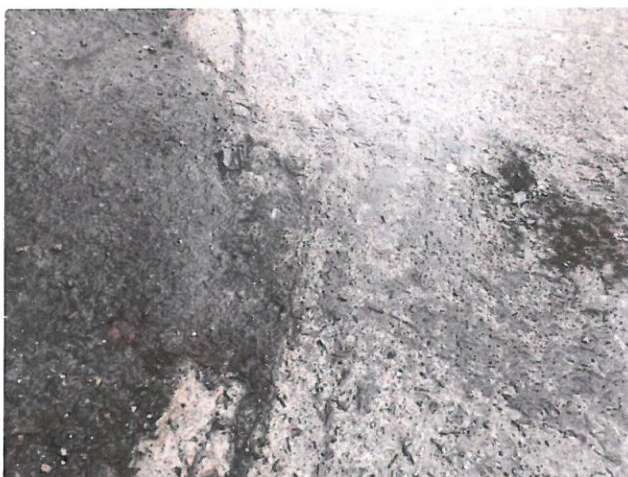
IMG_8128 - Na přechodu na mostovku na konci mostu jsou patrné trhliny, ale pravděpodobně těsné
