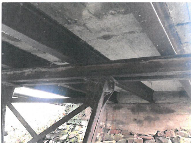
IMG_8200 - Dodatečné podepření NK je bez PKO, prozatím povrchová koroze, tvoří překážku v
